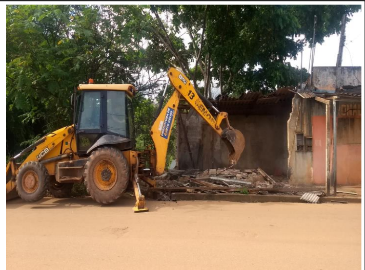
Fiscalização Demolitória realizada em invasão de APP. (margem canal)
