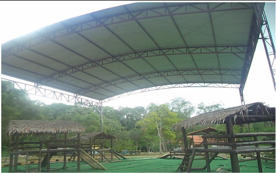
Construção realizada em 2018 – Cobertura de 225 m 2 do Playground.
